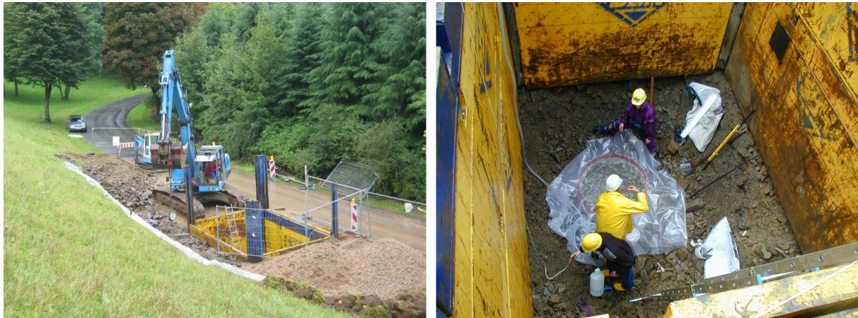
Bild 2: Schürfgarbe am Dammfuß und in situ-Dichtebestimmung
