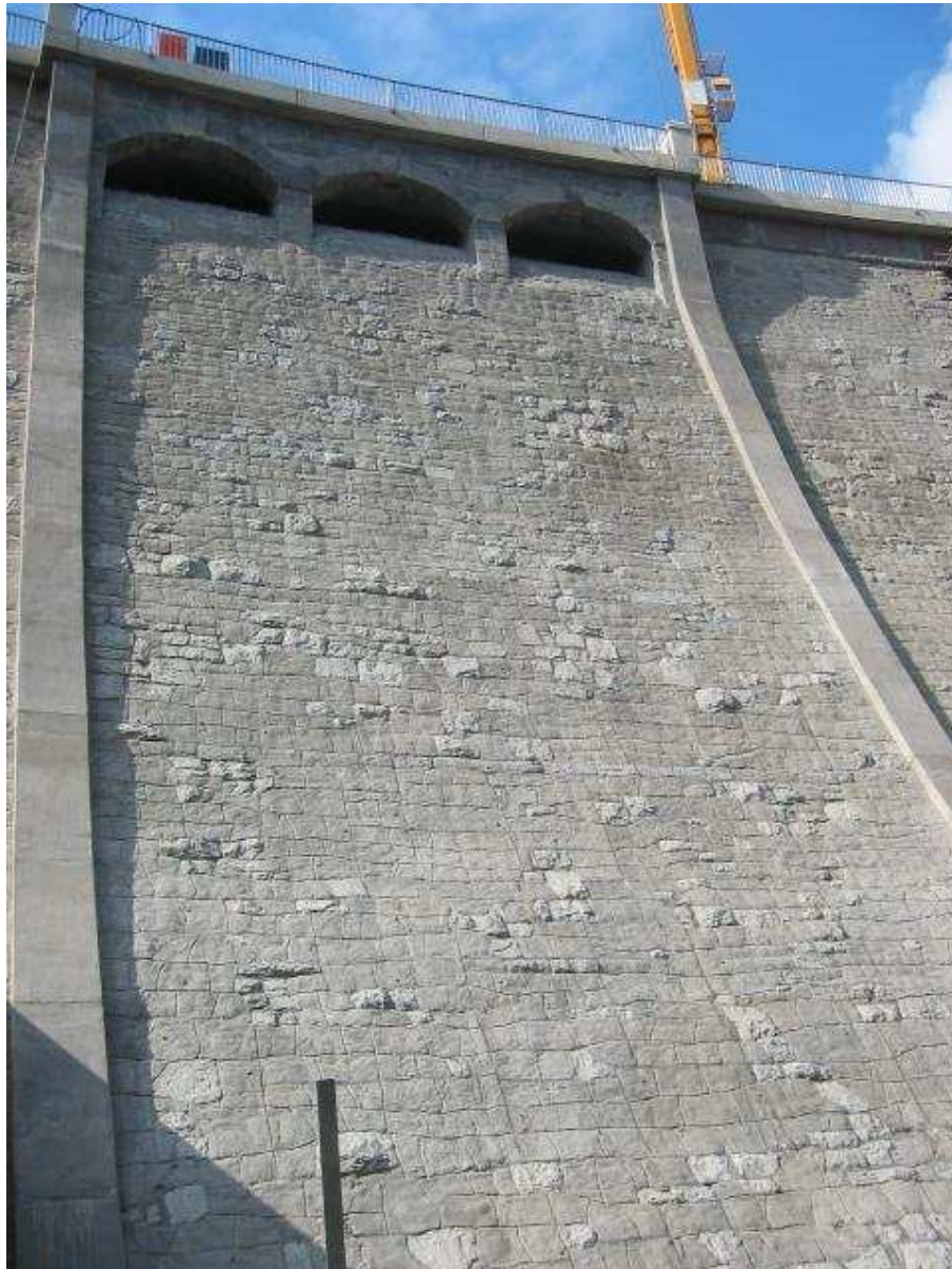
Bild 5: Luftseitige Maueroberfläche nach vollständiger Sanierung
