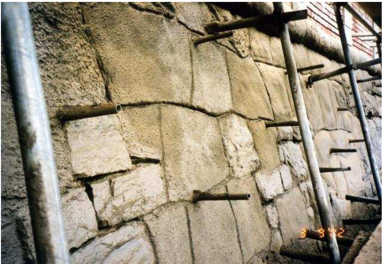
Bild 4: Maueroberfläche nach Spritzbetonsanierung (Gerüst noch nicht abgebaut)
