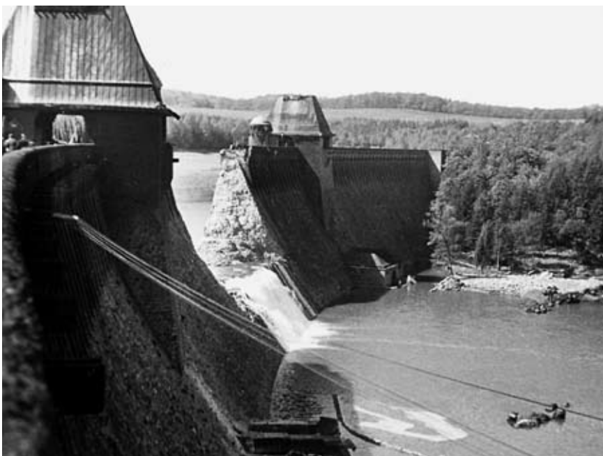
Bild 5: Bruch der Möhnestauer im Mai 1943 (Quelle Fotoarchiv Ruhrverband)
