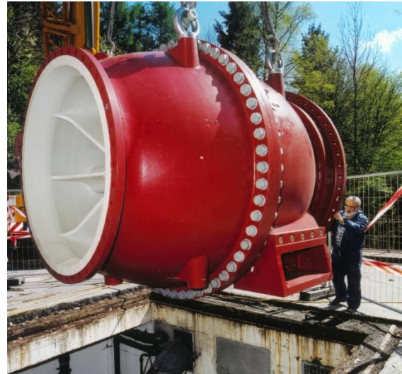
Einbau eines Ringventils an der Hennetalsperre
